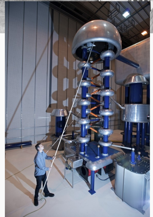
810 kV generator (PSI)
