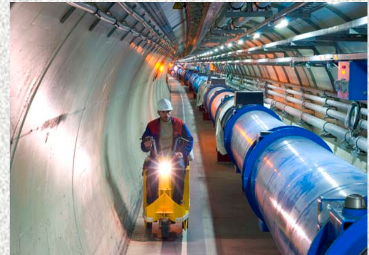
Túnel do LHC
