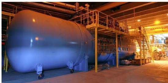
Cold box του 18 kW refrigerator @ 4.5 K
