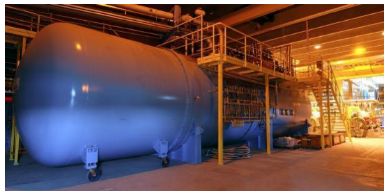
Cold box του 18 kW refrigerator @ 4.5 K
