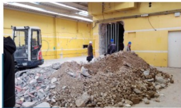
Perçement du corridor de circulation entre la future salle de contrôle et le bunker
