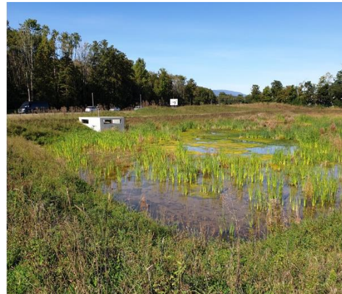
Bassin de rétention recevant les eaux de pluie du site de Prévessin du CERN, et permettant la régulation des rejets dans le Lion et la rétention de toute pollution accidentelle.
