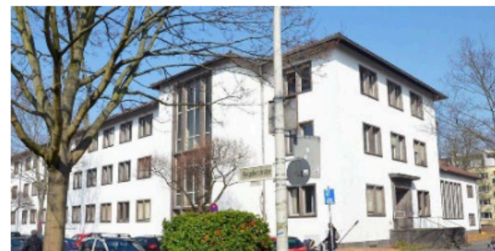
Abriss Alte Pharmazie
