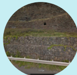
Galeries de perçage
