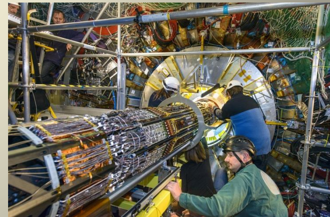
Vgradnja blaziničastega detektorja
