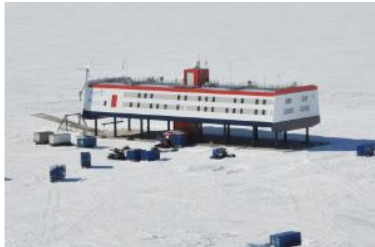
Neumayer III Station (Antarktis)
