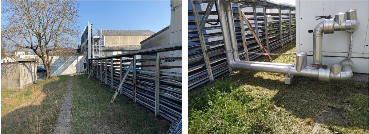
Figure 5 – Protections à prévoir au niveau du chemin de câble et des gaines de la CTA ext.
