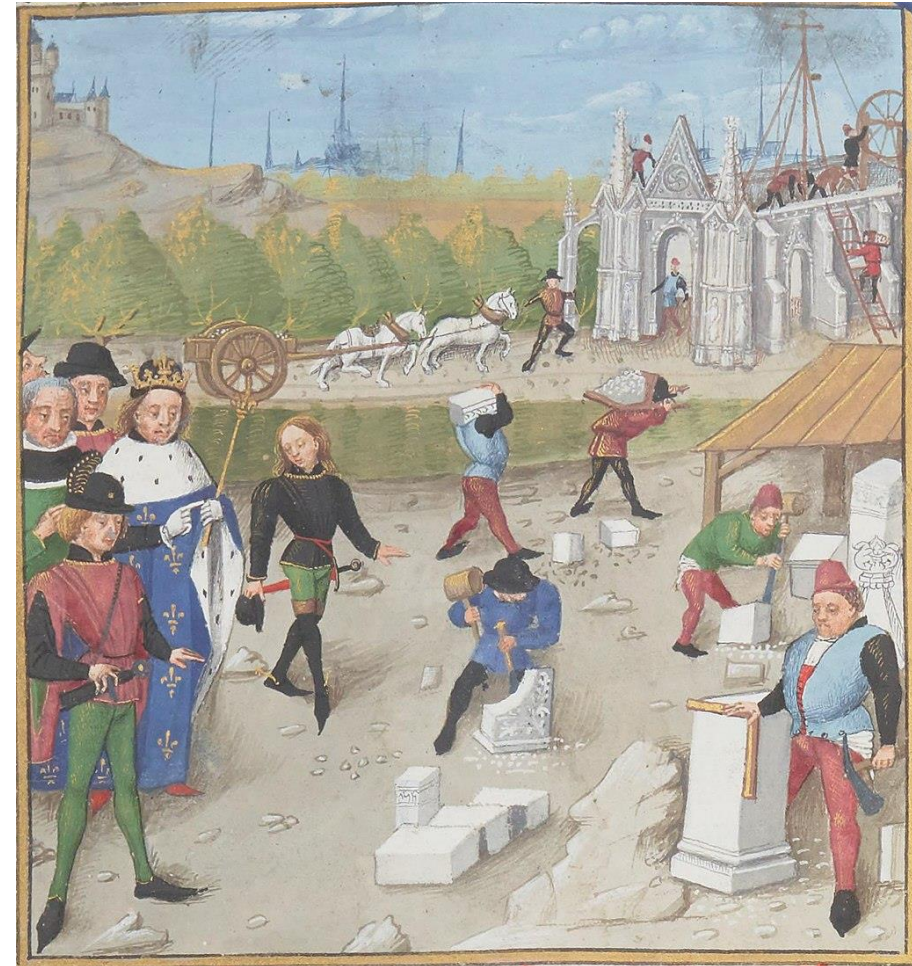
The construction site of Saint-Denis, "Les Grandes Chroniques de France", XIV c., Wikimedia commons
