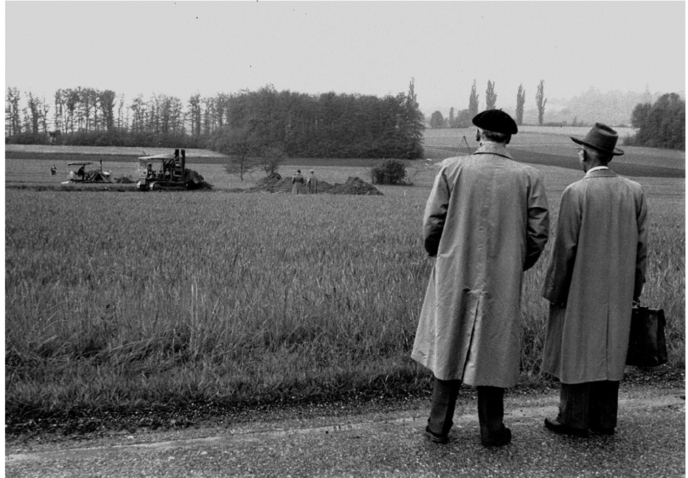
1954: Premiers travaux de construction pour la création du CERN
