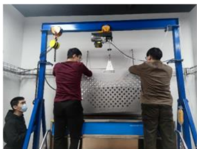
搬运转移出水箱
