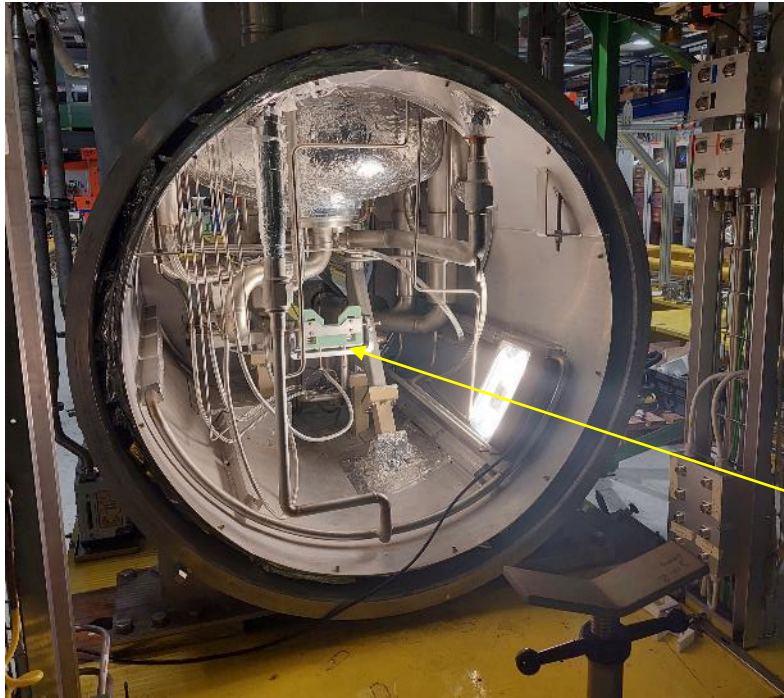
Antivrostas installation ongoing
