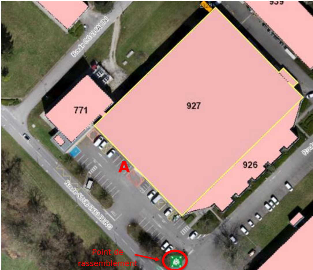
Figure 3 : Vue d'ensemble des bâtiments 771 et 927
