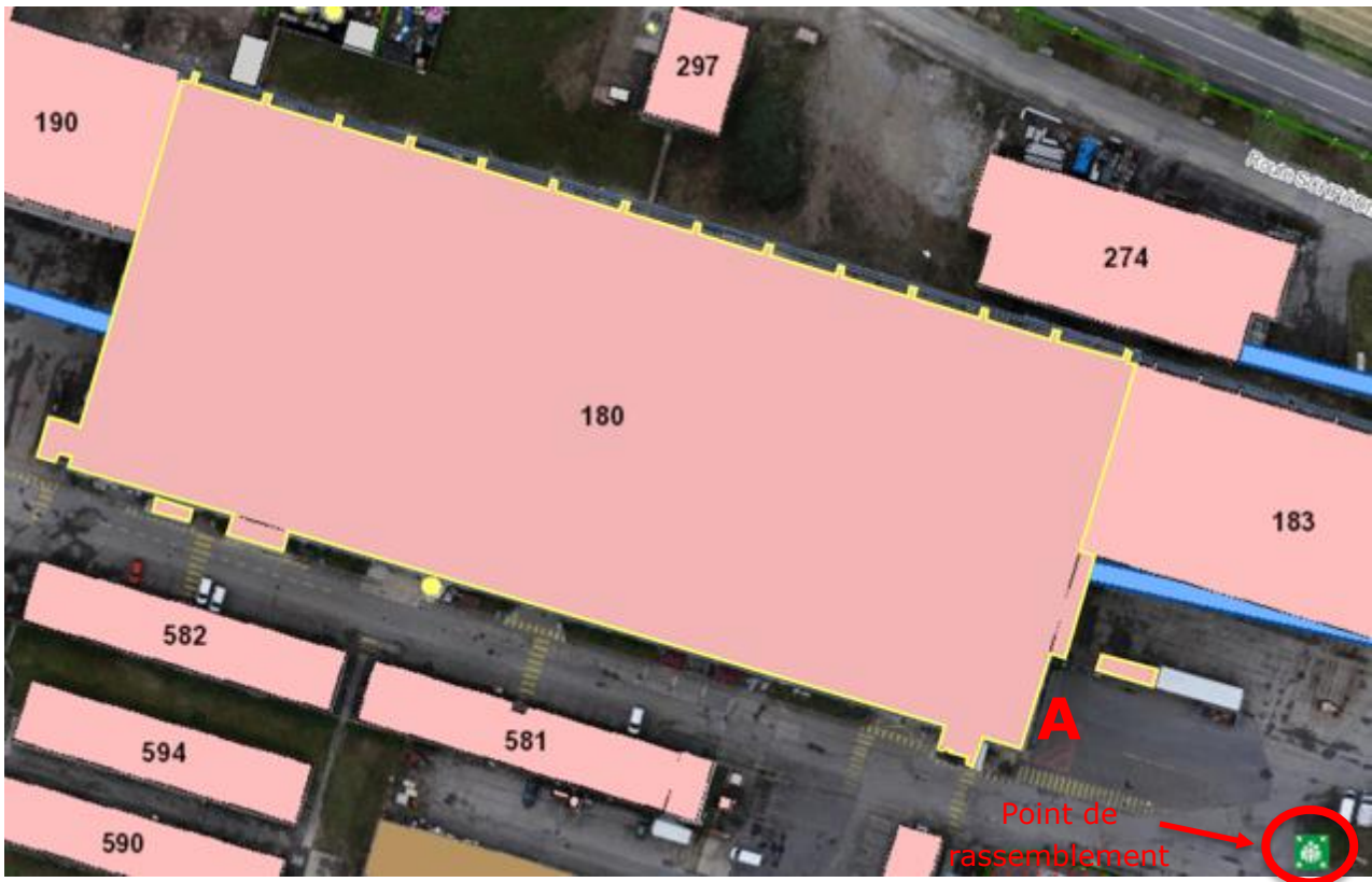
Figure 2 : Vue d'ensemble du bâtiment 180
