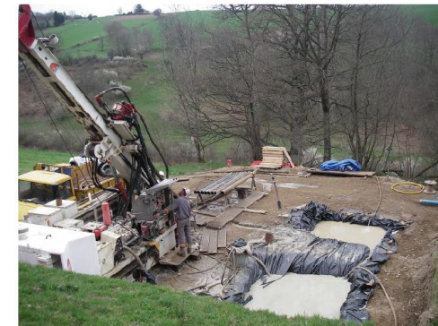
Sondage A89 (2007) incliné de 45° de 125 ml (surface plateforme estimée: 12 x 12 m soit environ 150 m²)
