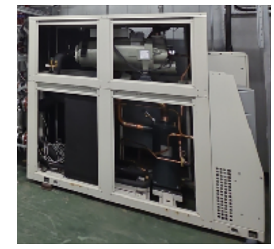
Heat pumps 3 x 200 KW, PUE 0.3*
