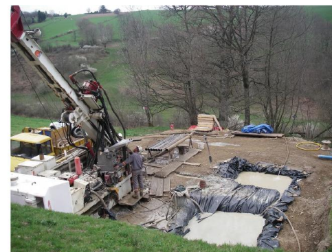
Sondage A89 (2007) incliné de 45° de 125 ml (surface plateforme estimée: 12 x 12 m soit environ 150 m²)
