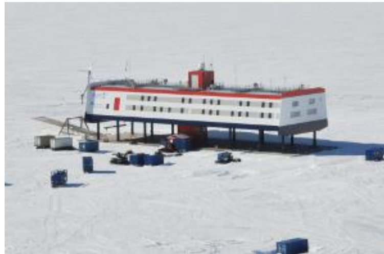
Neumayer III Station (Antarktis)
