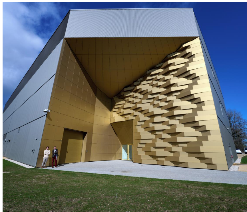
CERN Préveessin Data Center
