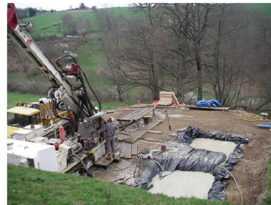
Sondage AB9 (2007) incliné de 45° de 125 ml (surface plateforme estimée : 12 x 12 m soit environ 150 m²)
