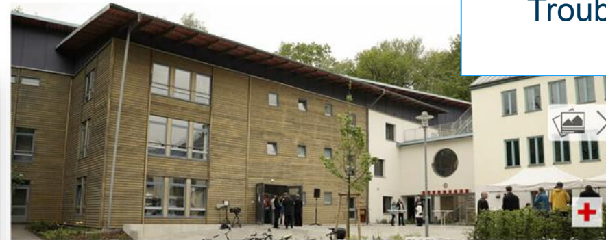
Die Standorte, wie hier am GFZ Potsdam, sollen klimaneutral werden. FOTO: SEBASTIAN GABSCH PNN
