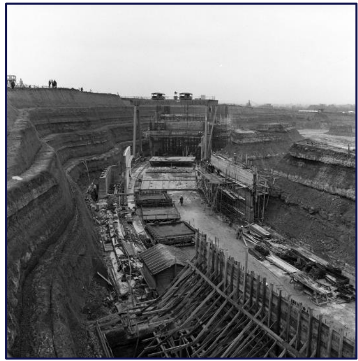
Complexe ISR en construction – 1967 (Dumez et Hochtief)
