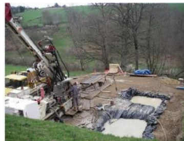
Sonotage ABS (2007) incliné de 45° de 125 m (surface plateforme estimée : 12 x 12 m soit environ 150 m²)
