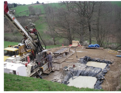
Sondage AB9 (2007) incliné de 45° de 125 m (surface plateforme estimée : 12 x 12 m soit environ 150 m 2 )
