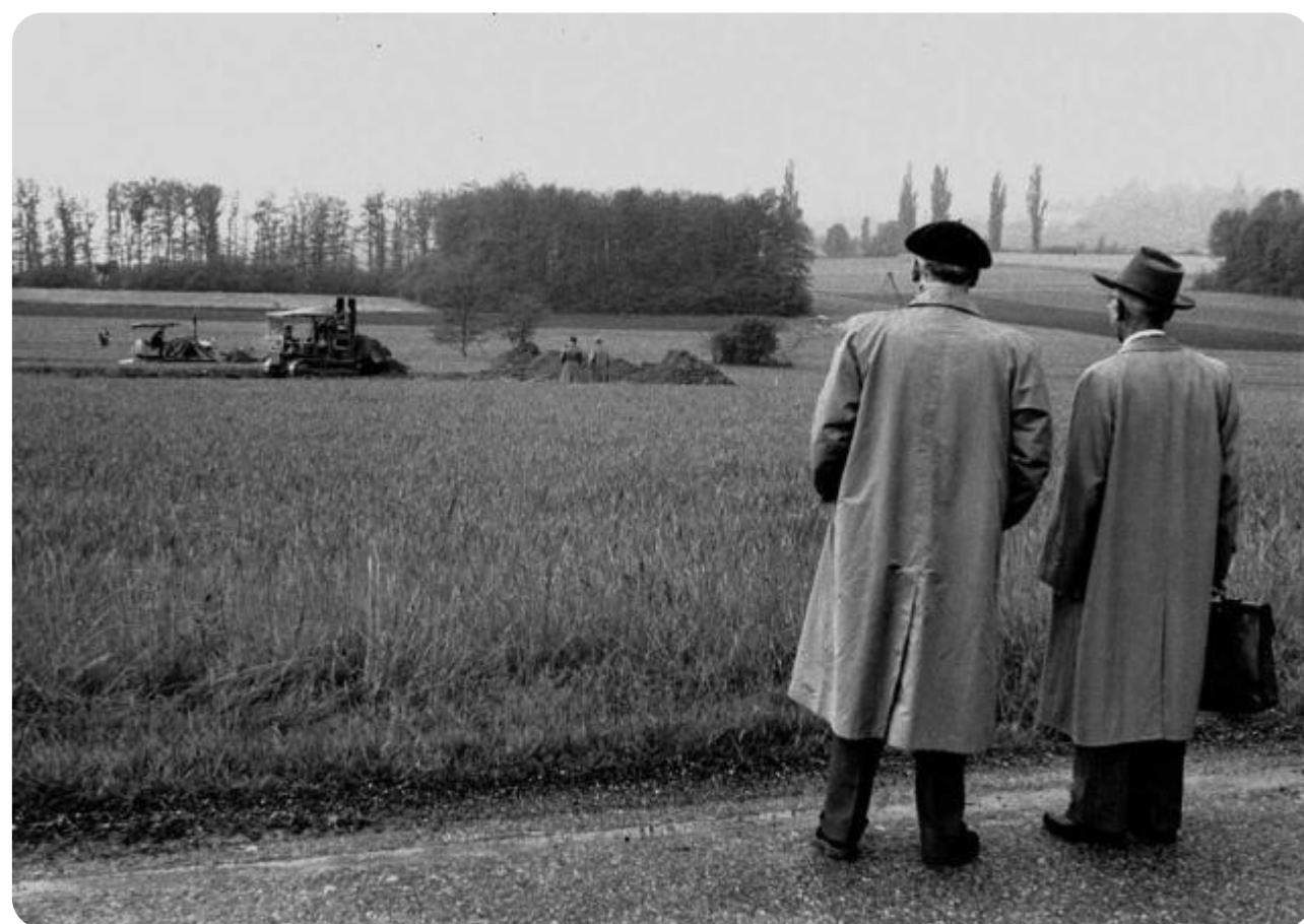
Fotografia pred začatím prvých prác.
