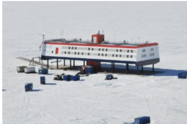
Neumayer III Station (Antarktis)
