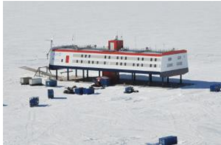
Neumayer III Station (Antarktis)
