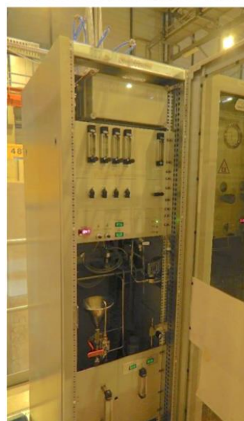
Gas recirculation module
