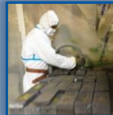
Etape n°2: Aspiration des poussières à la surface des briques de plomb
