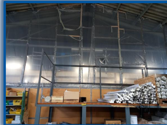
Vue de la bâche installée entre les locaux R-401 et R-402 du bât.131
