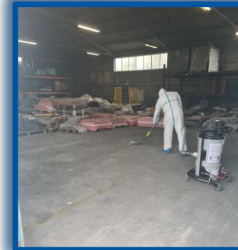
Aspiration des poussières accumulées sur le sol
