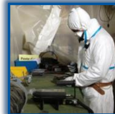
Etape n°3: Mesures radiologiques sur chaque brique de plomb
