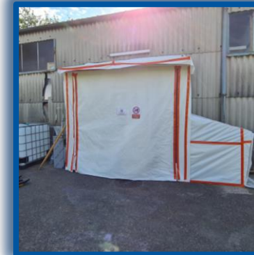
Vue extérieure de l'entrée du local R-401
