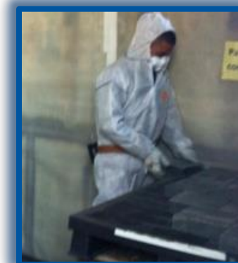
Etape n°4: Conditionnement du plomb contrôlé sur des palettes
