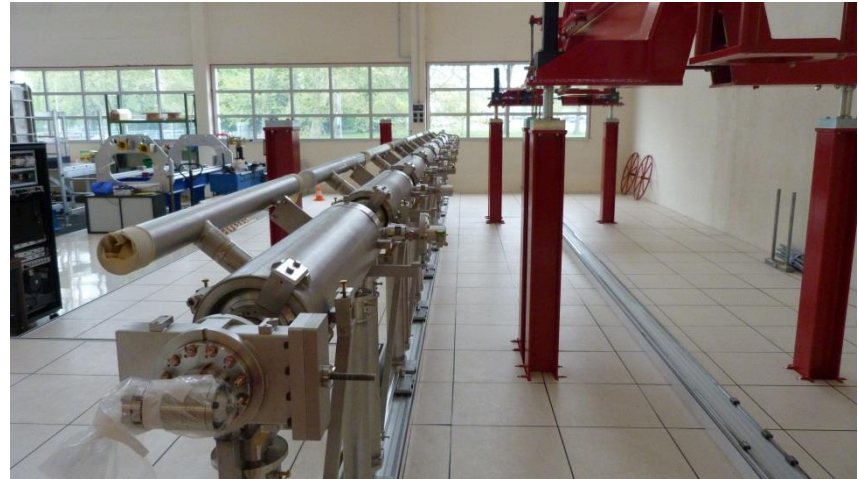
Roulage du train de cavités hors salle blanche
