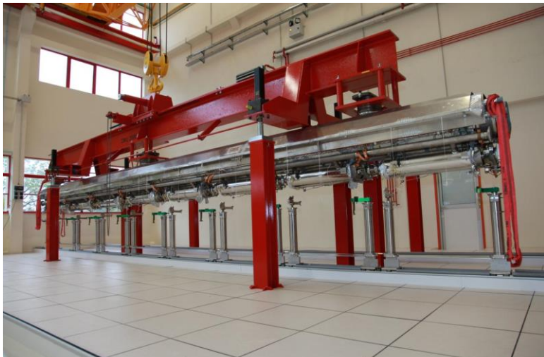
Arrimage du train de cavités au cryostat
