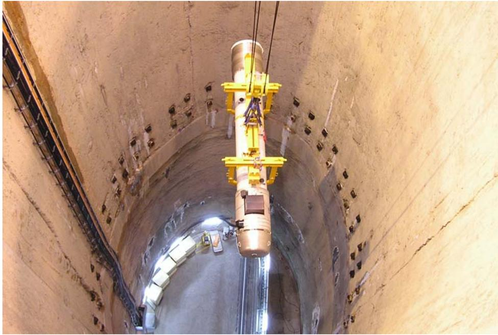
Pendant la préparation de série des aimants pour l'installation du LHC, ce bâtiment a vu transiter tous les dipôles principaux (1232 unités) et tous les quadripôles SSS (474 unités) en plus des autres aimants et équipements spéciaux, pour la préparation finale et l'installation dans le tunnel via le puits présent dans le bâtiment adjacent SDI2.
