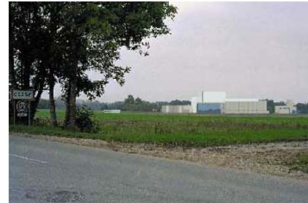
Vue du Point 5 côté village : de la phase 1 ...
