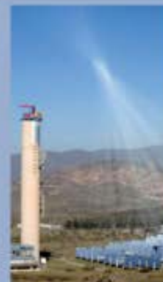
Plataforma Solar de Almería
