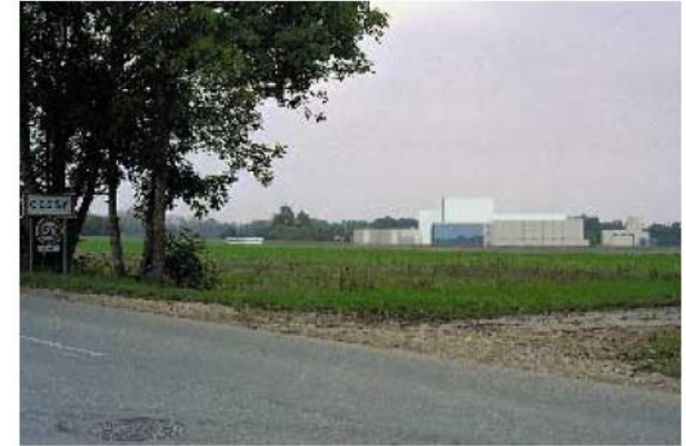
Vue du Point 5 côté village : de la phase 1 ...
