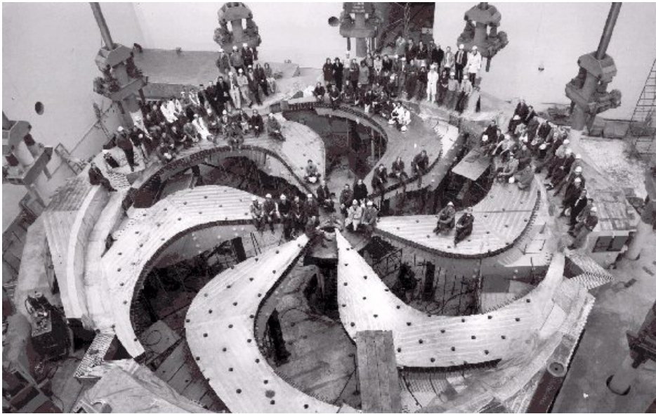
TRIUMF 520 MeV proton cyclotron (Vancouver, Canada)
