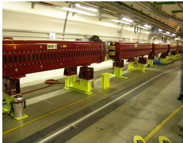
Для транспортировки пучков с энергией 450 ГэВ из протонного синхротрона SPS в коллайдер LHC построены два канала транспортировки пучка, T12 и T18, протяженностью около 2.5 км каждый. В рамках участия Российской Федерации в проекте LHC Институт ядерной физики им. Г.И. Будкера поставил в ЦЕРН 360 дипольных магнитов (MBI), 180 квадрупольных магнитов (MQI) и 100 корректирующих магнитов для формирования траектории пучков при их перепуске из SPS в основное кольцо коллайдера.
