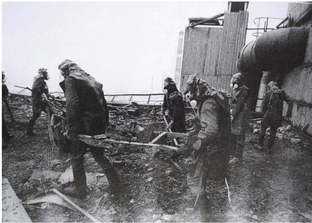
Photo des « biorobots » sur le toit de la centrale
