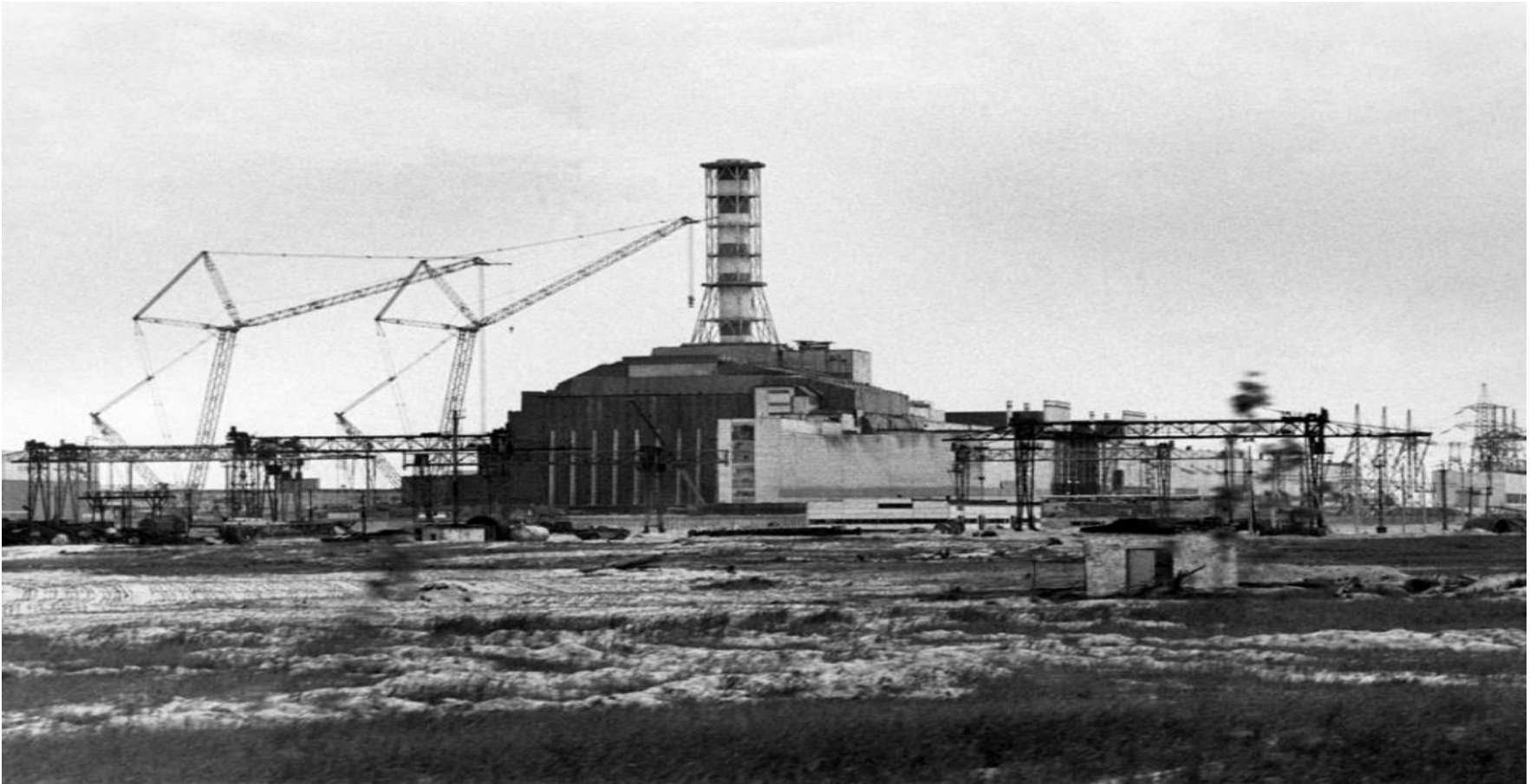
Photo des travaux sur la centrale après l'explosion
