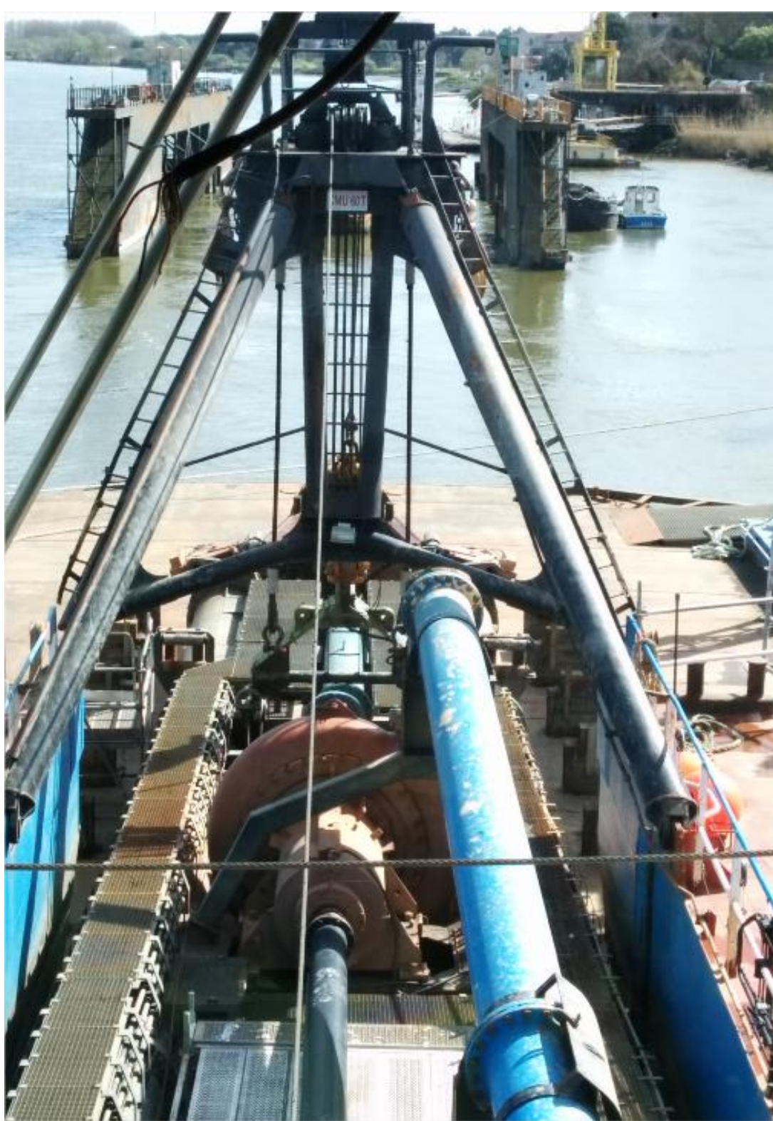
Avant de la plate forme mobile permettant de draguer la Loire.
