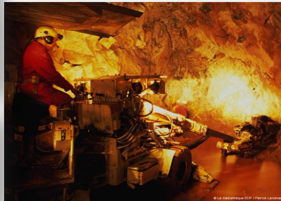
Une foreuse à eau sous haute pression
