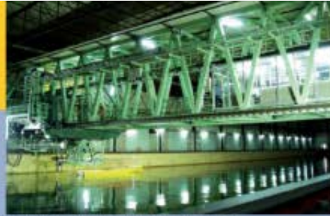
Canal de Experiencias Hidrodinámicas de El Pardo
