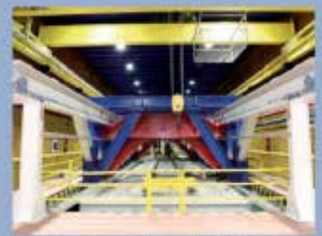
Instalación de Ingeniería Civil del CEDEX
