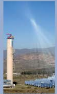
Plataforma Solar de Almería
