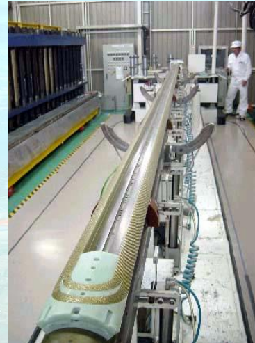
超伝導ケーブルを巻く作業(東芝京浜工場)
