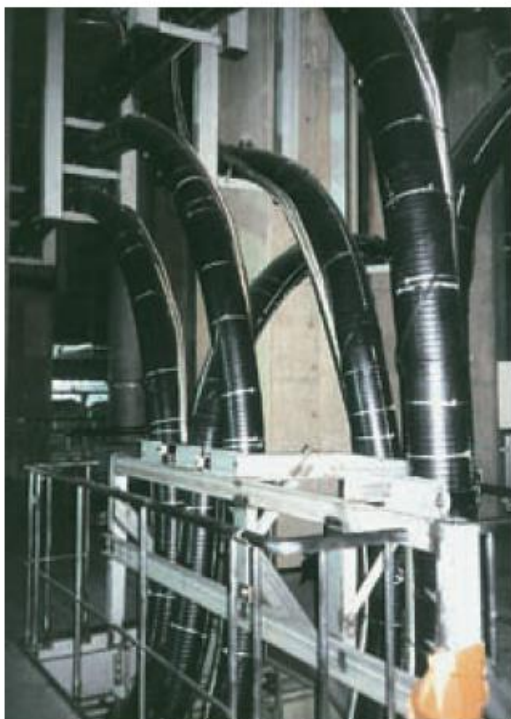
Supraleitendes LTS-Kabel für die Fusionsforschung in Japan (NIFS) Superconducting LTS cable for Fusion Science in Japan (NIFS)
