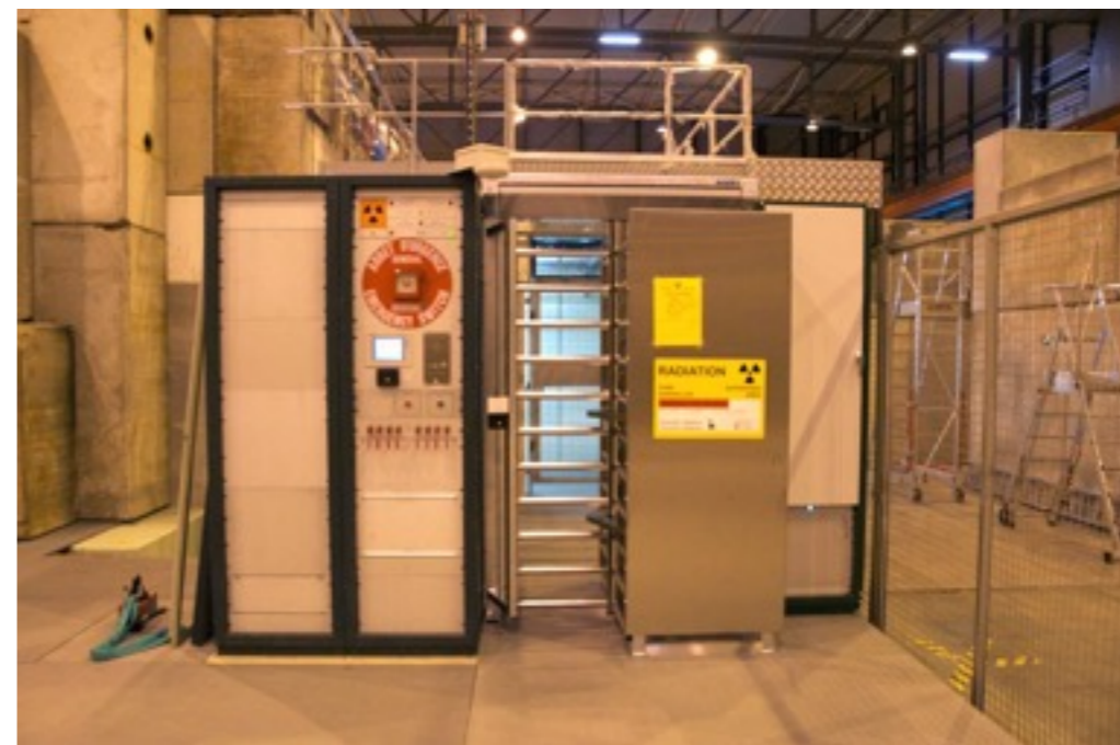
GIF Bunker / H4 - 154
