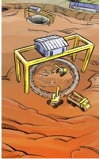
BEVOR GEGRABEN WERDEN KONNTE, MUSSTE DER BODEN UM DIE SCHÄCHTE MIT FLÜSSIGEM STICKSTOFF GEFROREN WERDEN, UM EINE ÜBERFLUTUNG ZU VERMEIDEN, ALS DIE BAGGER DEN GRUNDWASSERSPIEGEL IN 40 M TIEFE ERREICHTEN.
