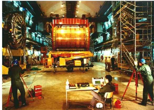
Fig. 5 : contrôle du montage de Opal - 1987
