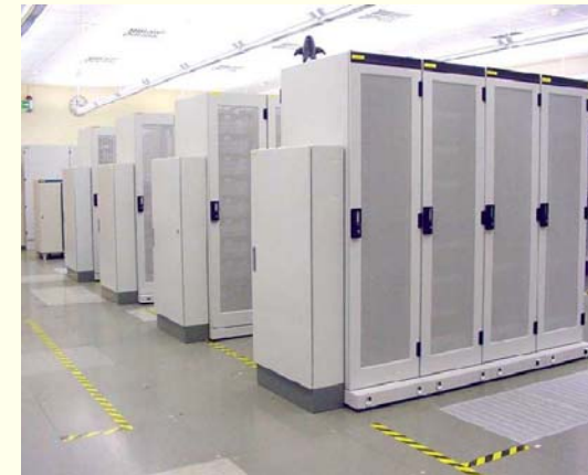
Hala w ośrodku obliczeniowym Tier-1 w Karlsruhe, Niemcy.
