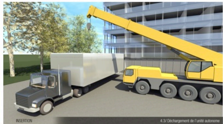
4.3/ Déchargement de l'unité autonome
