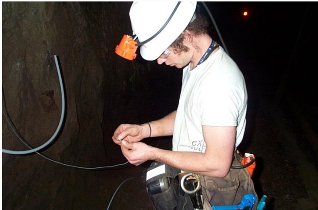
Jason Van Beek terminating data cable
