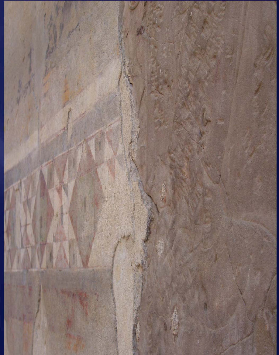
Przekrój malowidła ściennego
